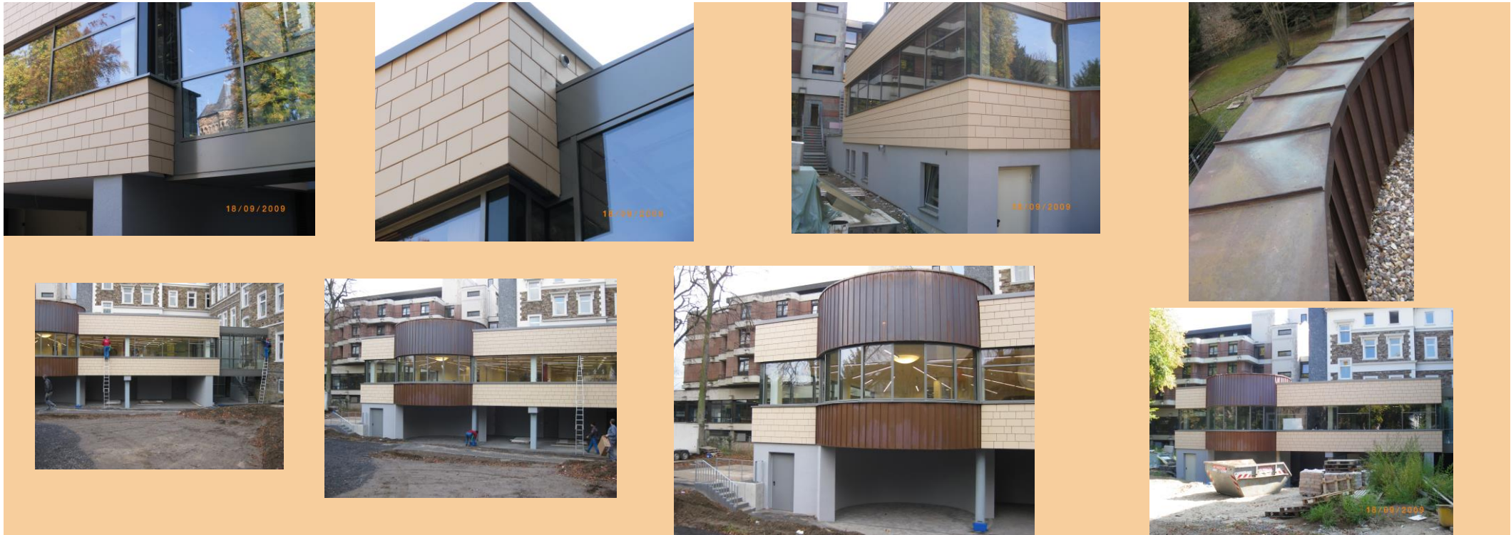
2009 BAD-NEUENAUHREHRENSWALSCHER KLINIK CA. 135 M 2 MOEDING- ZIEGELFASSADE
